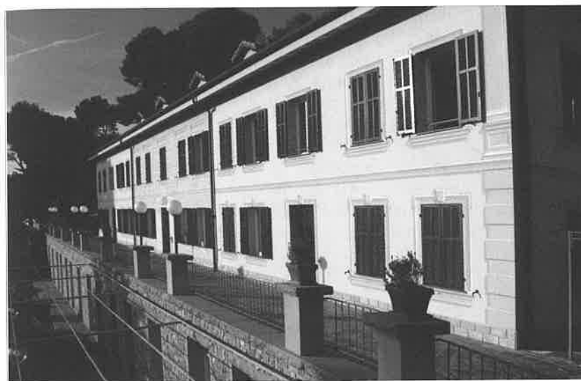
L'edificio della comunità educativa
