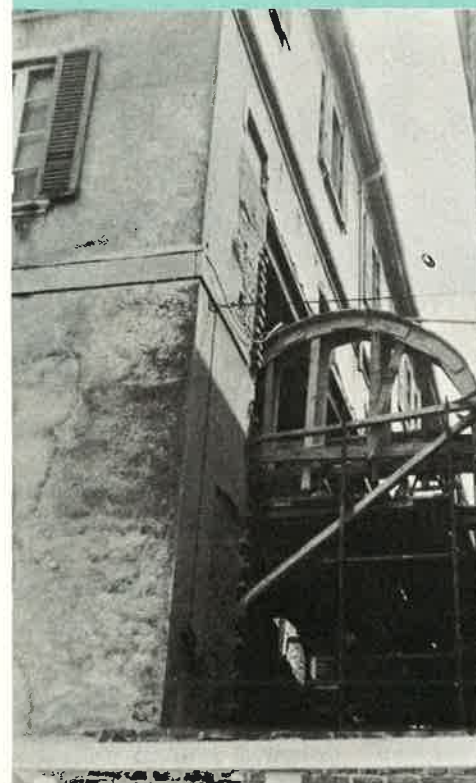
Una visione dei lavori del piazzale antistante la chiesa
