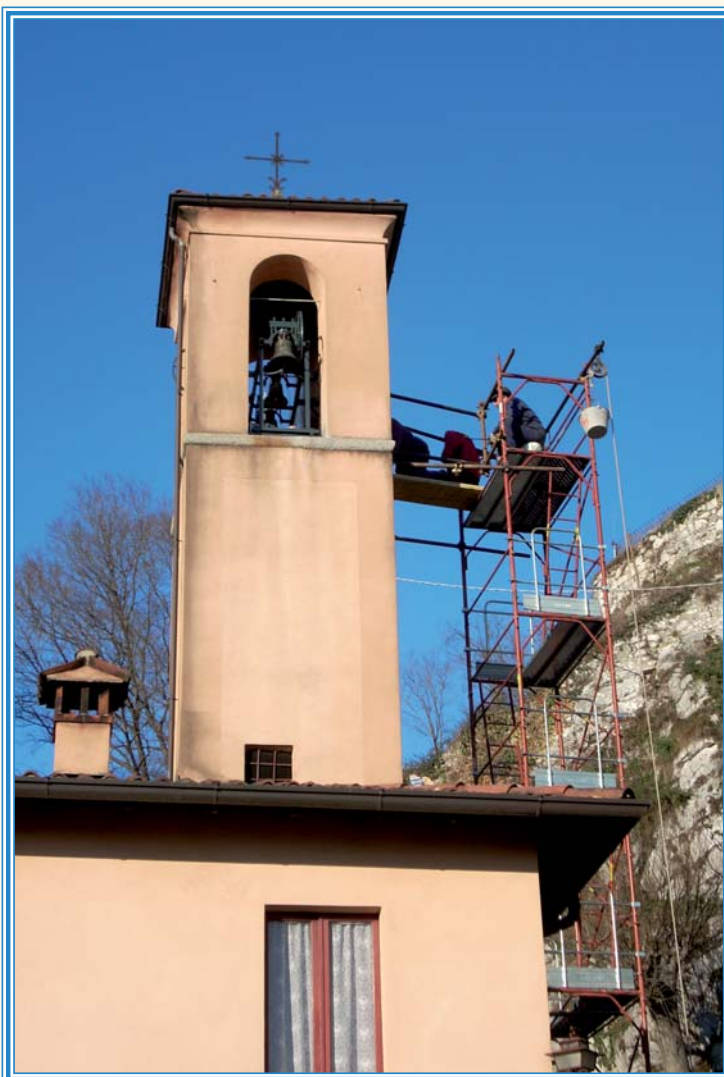
Somasca - La sistemazione delle campane alla Valletta
