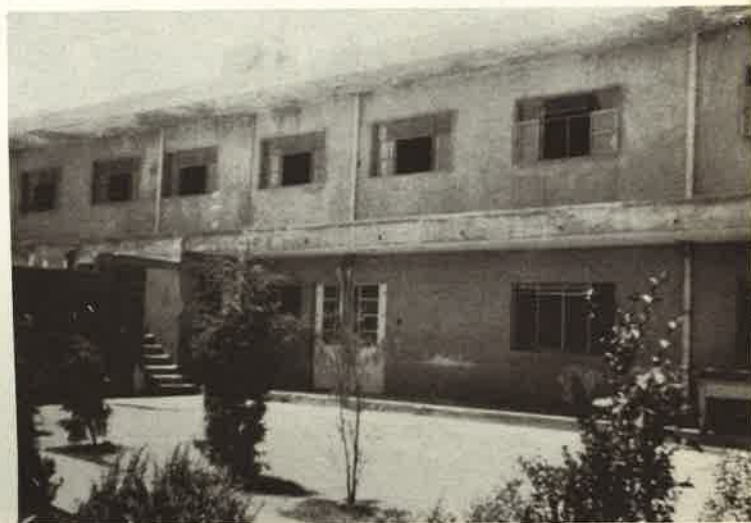
La casa del Seminario in costruzione.
