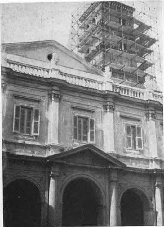
Lavori al campanile della Basilica di S. Alessio in Roma.
