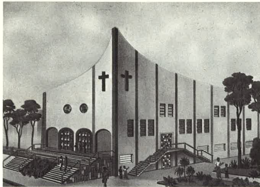
S. André: Il progetto della Parrocchia del Rosario, oggi in avanzata fase di costruzione
