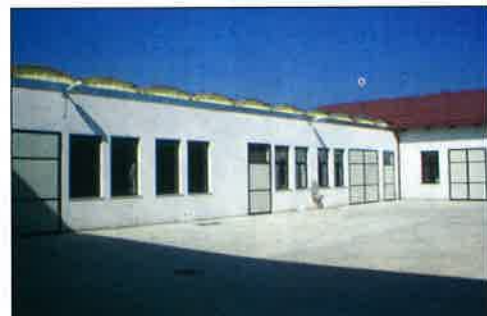
Locali per la formazione con ufficio, sala ricreativa, spogliatoi e servizi igienici.
