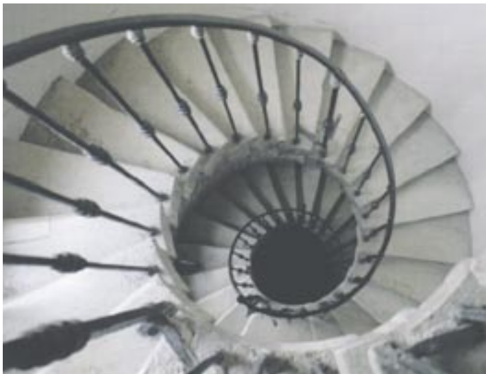
La scala di servizio nell’angolo sud-est del complesso
