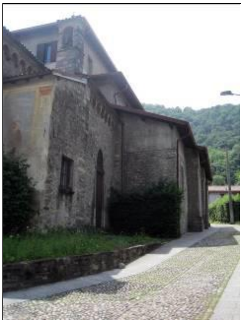
Olginate: La chiesa conventuale di S. Maria la Vite (vista da valle)
