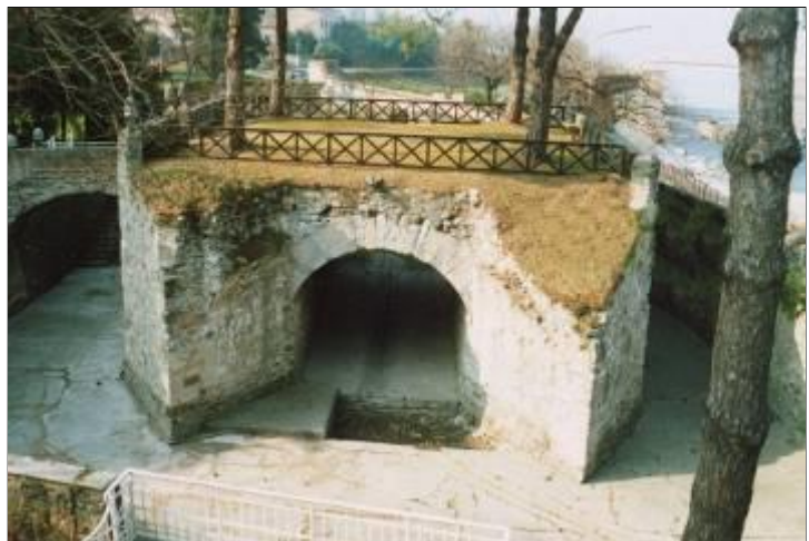
Grande arco inglobante la testata del ponte romano sull'Adda
