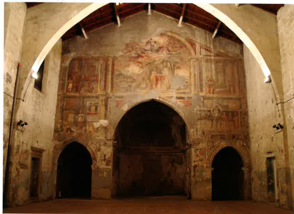
A destra: Figg. 26 e 27 - La parete presbiteriale e la parete occidentale dopo i restauri.
