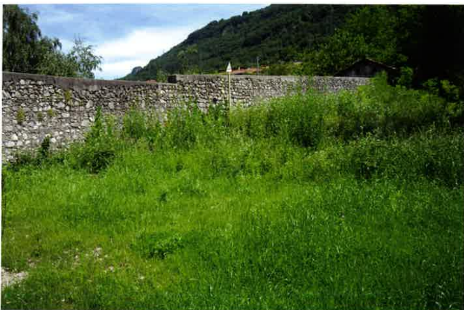
Il muro settentrionale del Corpo di Guardia che seguiva il corso del torrente di Val Busa
