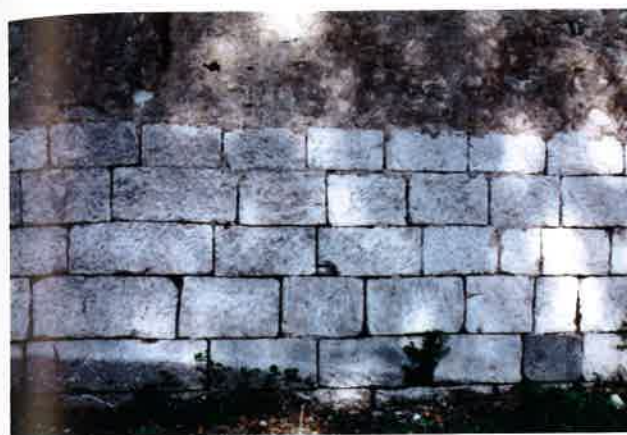
Parte della muraglia di età comunale come appariva nel 1979. Sotto: la lapide confinaria collocata nel 1759 e ora asportata
