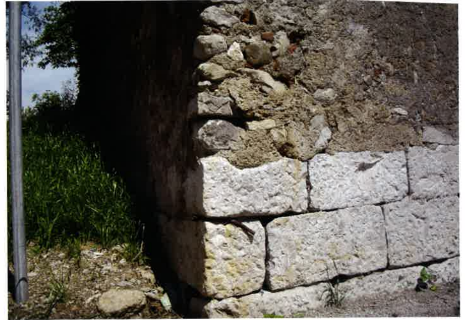
La corretta finitura delle mura medievali riprese durante i lavori del 2012
