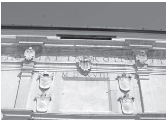
Fig. 8. Porta San Tomaso – lato interno
