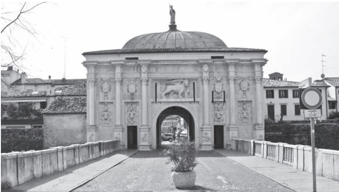
Fig. 7. La Porta San Tomaso
