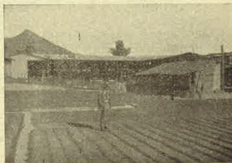
Interno dell'edificio nuovo con caffè a seccare.
