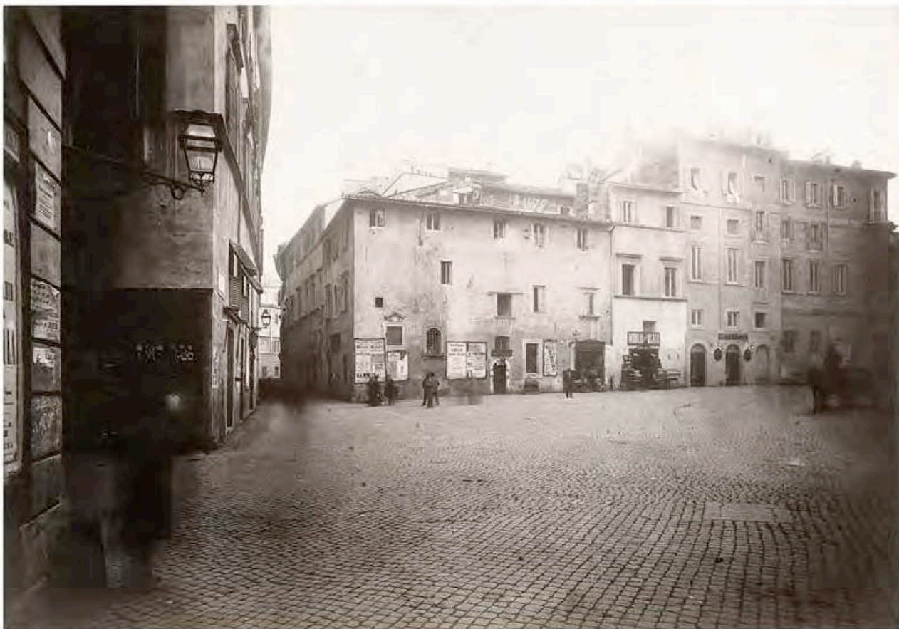
Fig. 2. L'insula Caffarelli dopo la demolizione delle case avanti S. Andrea della Valle
