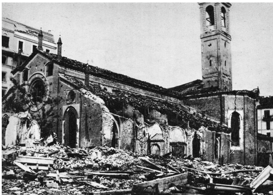
Figura 6 — Fiancata destra della chiesa nell'agosto-settembre 1943. (Fonte: Comune Milano)
