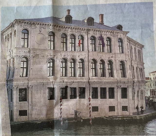
Palazzo dei Camerlenghi, proprio accanto al Ponte di Rialto
