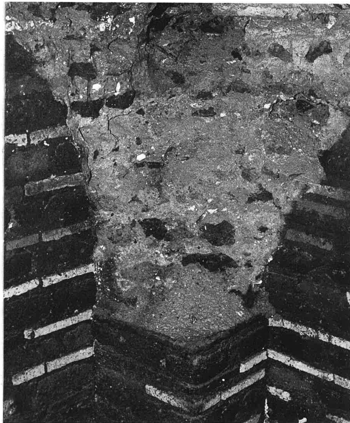
7. Tomba Truzzi: pilastro angolare di nord-est con traccia della volta in conglomerato e parete in opera listata
