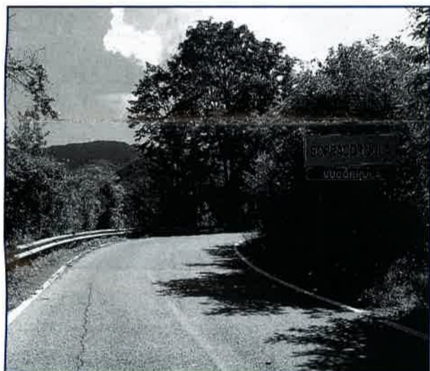
La strada per Sopracornola a lavori ultimati
