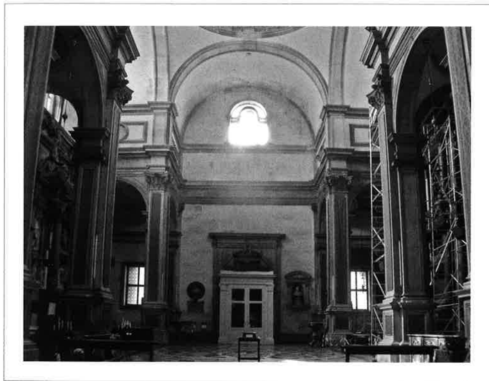
Fig. 2. Chiesa di San Salvador. La controfacciata allo stato attuale.
