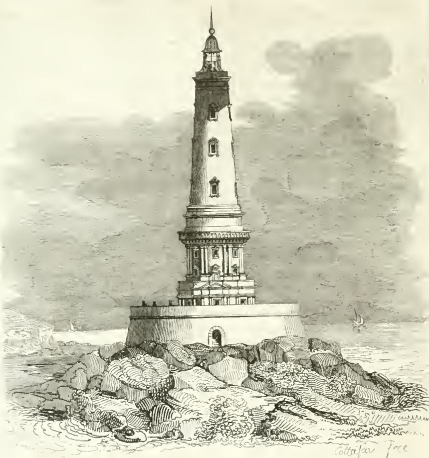
LA TORRE DI CORDOUAN
