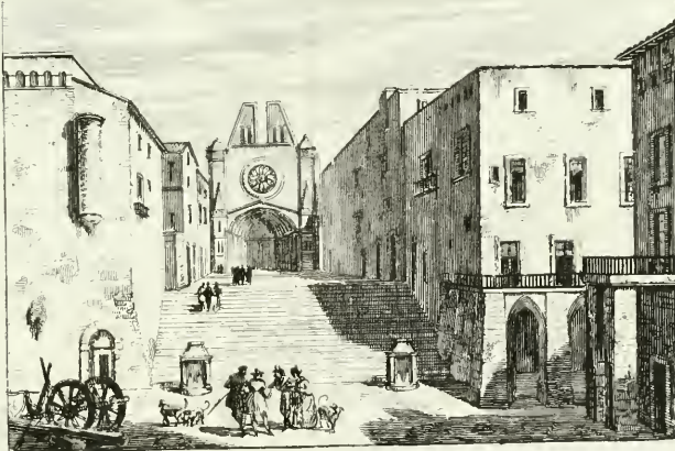
VEDUTA DELLA CHIESA CATTEDRALE DI TARRAGONA
