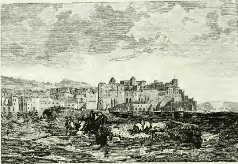
(Pozzuoli veduta dal molo di Caligola)
