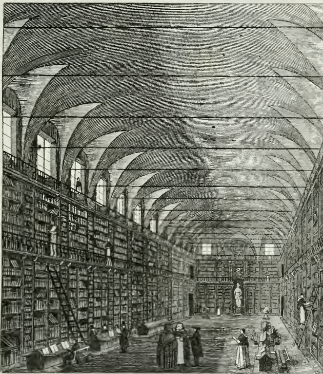
(Interno della biblioteca Casanatense)
