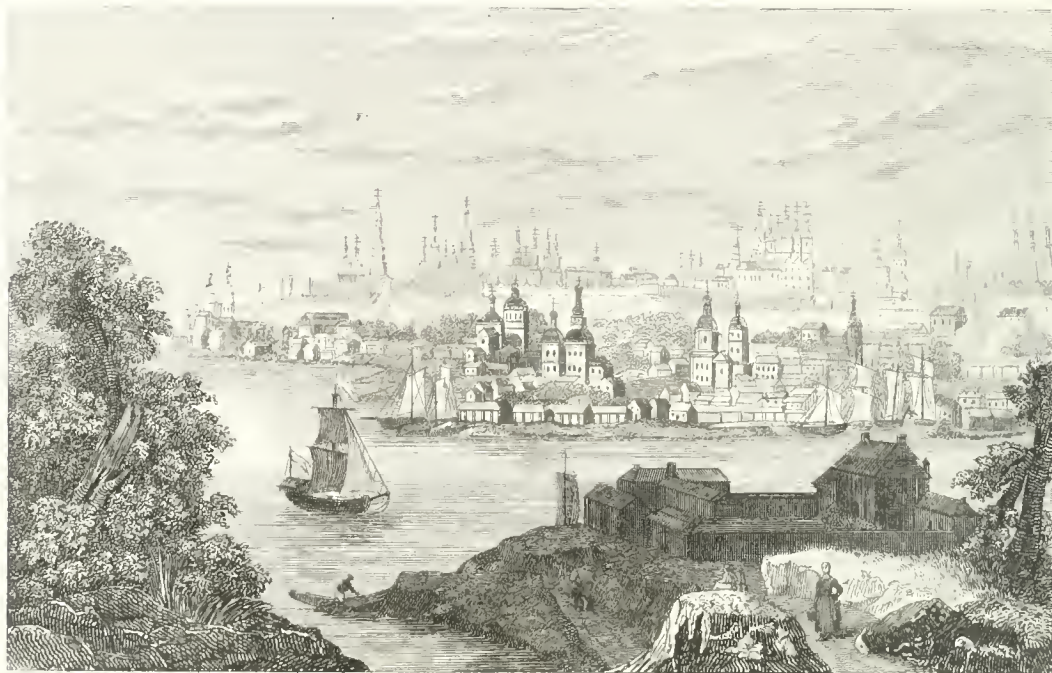
VEDUTA DELLA CITTA' DI CASAN (innanzi l'incendio del mese di settembre 1842)
