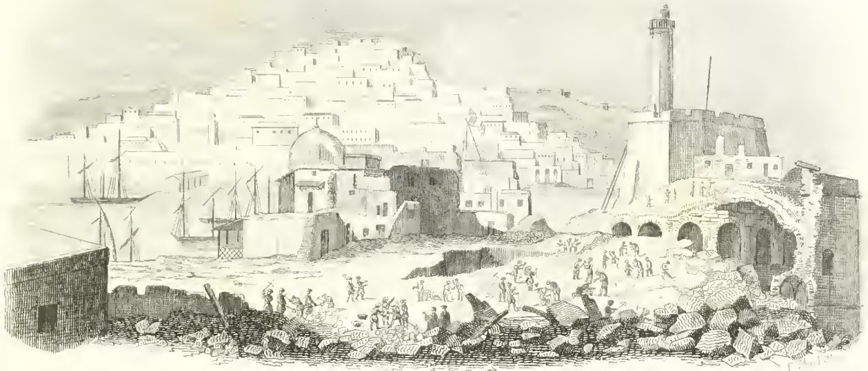
(Stato dei luoghi dopo l'esplosione.)
