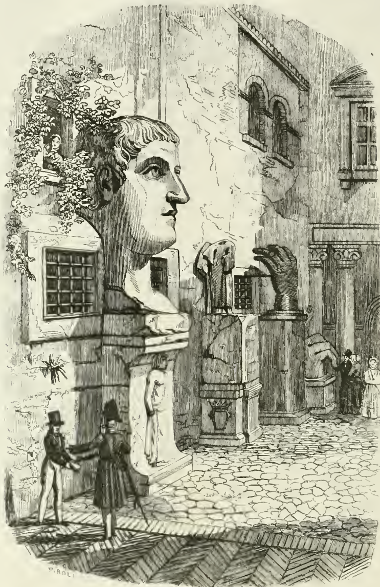
( Framenti colossali esistenti nel cortile del Palazzo de' Conservatori. )
