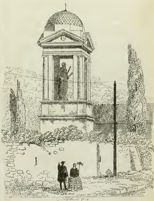
IL TEMPIETTO DI S. ANDREA IN PROSSIMITA' DEL PONTE MILVIO.
