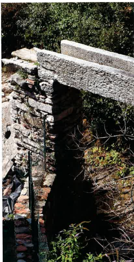
Residuo della canalizzazione in pietra appartenente ad un molino scomparso nel centro di Corneno
