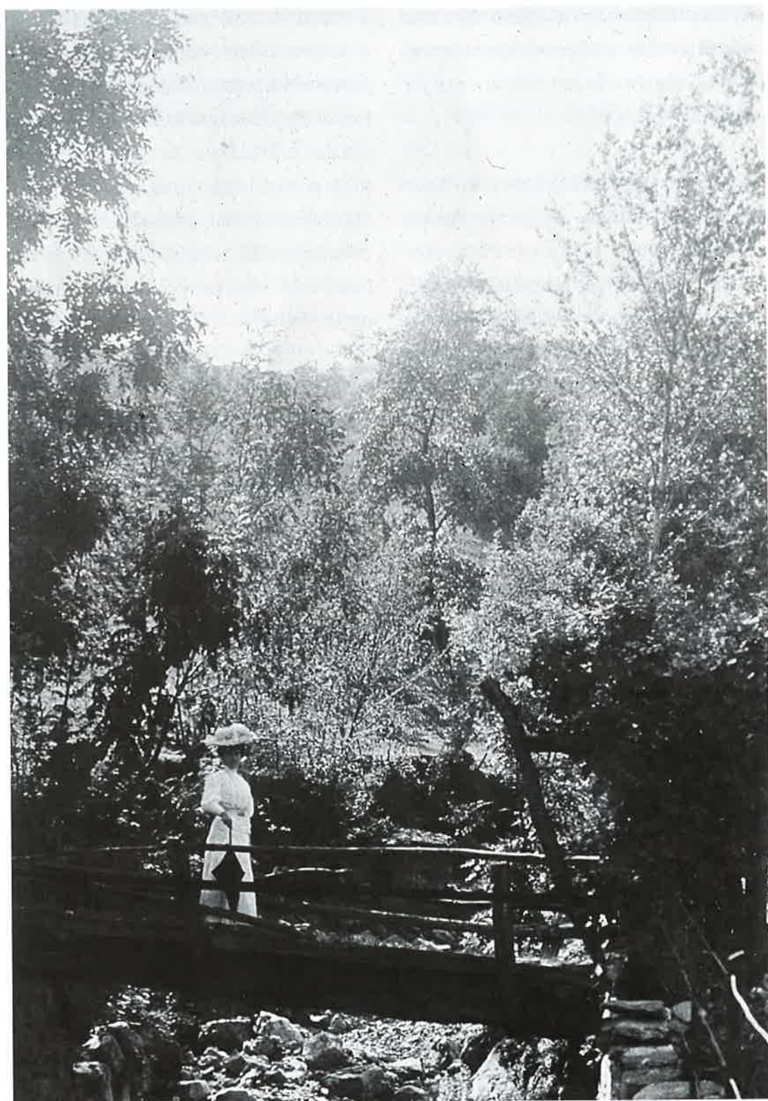
La dama con l'ombrellino sopra un ponticello scomparso del centro storico di Corneno. Foto d'epoca.
