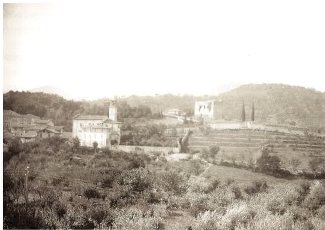
Veduta fine 800 di Galliano con la torre e le mura
