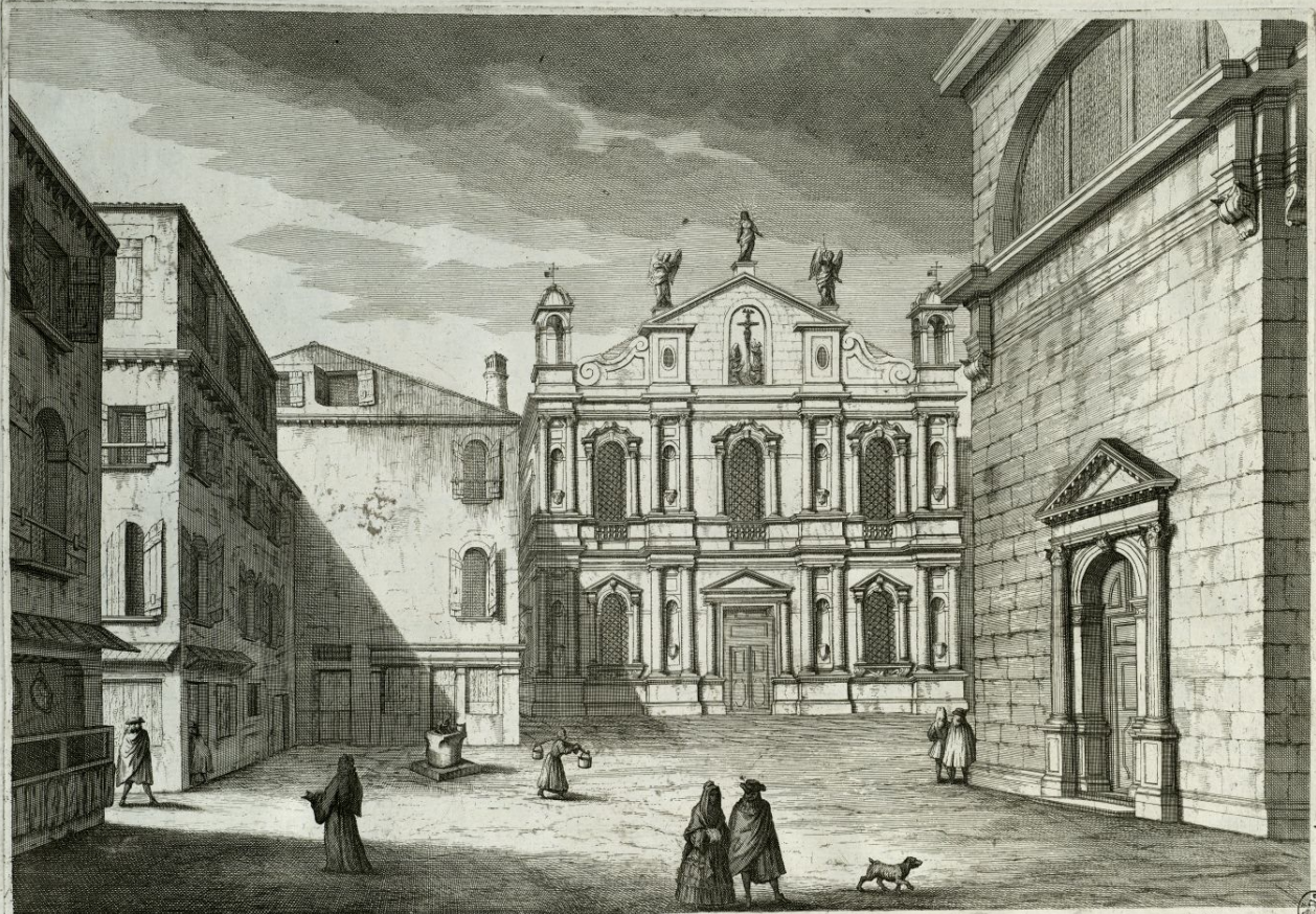
Veduta della Chiesa, e Scuola di S. Fantin in V E N E T I A.
