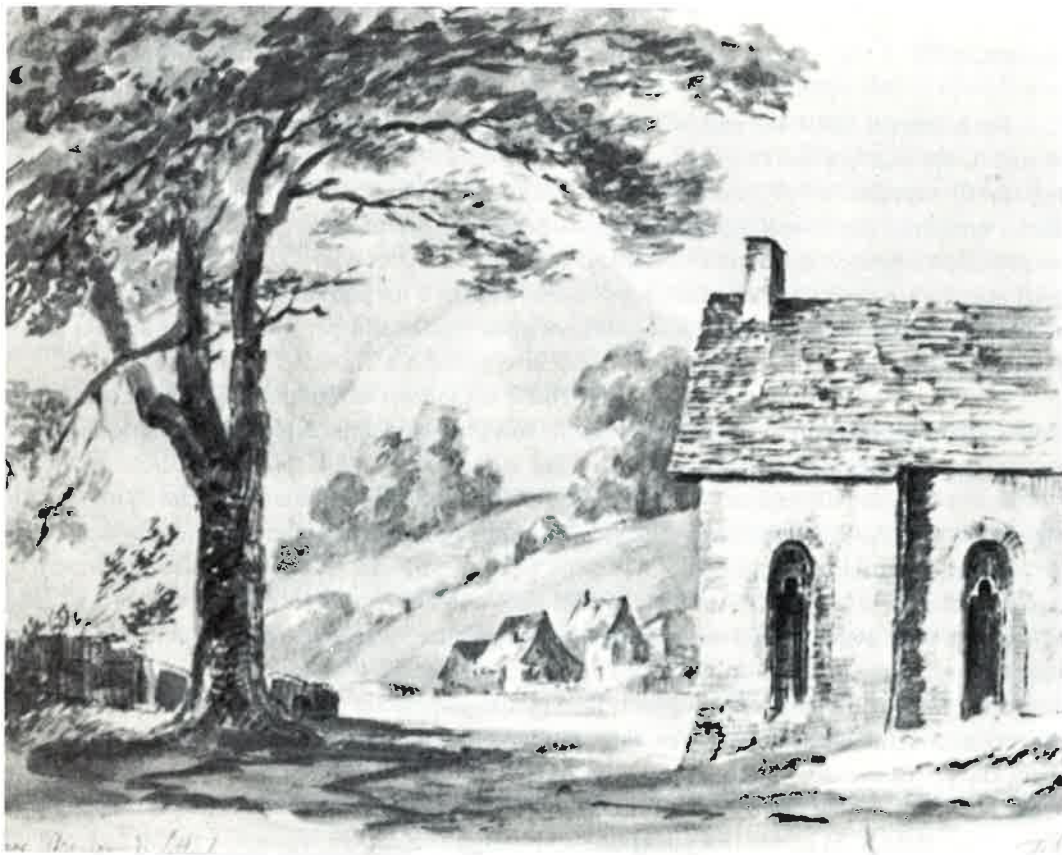
Fig. 19 - Il Fracc (Fraggio), contrada di Taleggio, oggi pressoché in rovina - (dis. di A. Marenzi).
