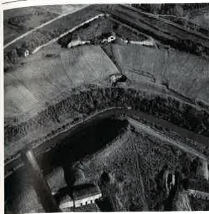
19. Fortezza di Palma (nova), il bastione realizzato, dotato di logge; quella a sinistra è in comunicazione col fossato attraverso una « sortita » che termina con una falsa porta. L'impianto difensivo appare ulteriormente munito in profondità, verso la campagna, dalla lunetta di fabbricazione francese comprendente al centro la « caponiera » e ai lati due corpi di guardia.
