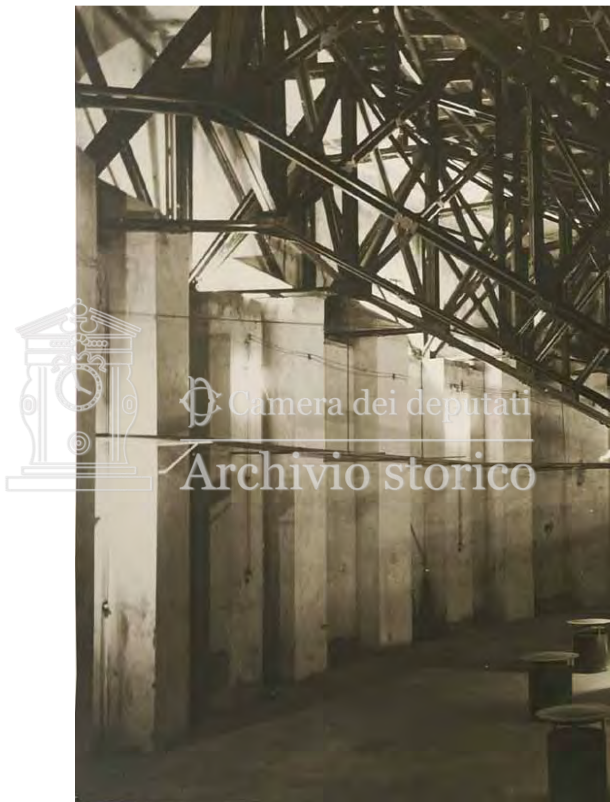
Camera di ventilazione dell'Aula, con armatura di sostegno degli stalli
