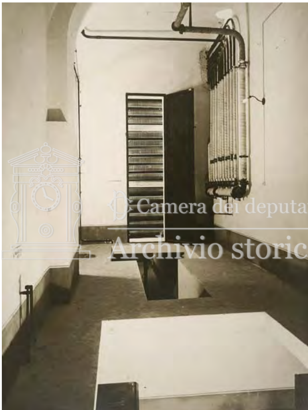
Batteria di riscaldamento
