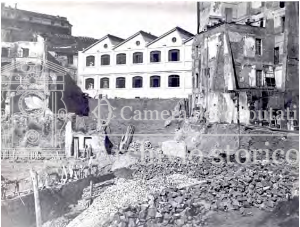
Area del cantiere
