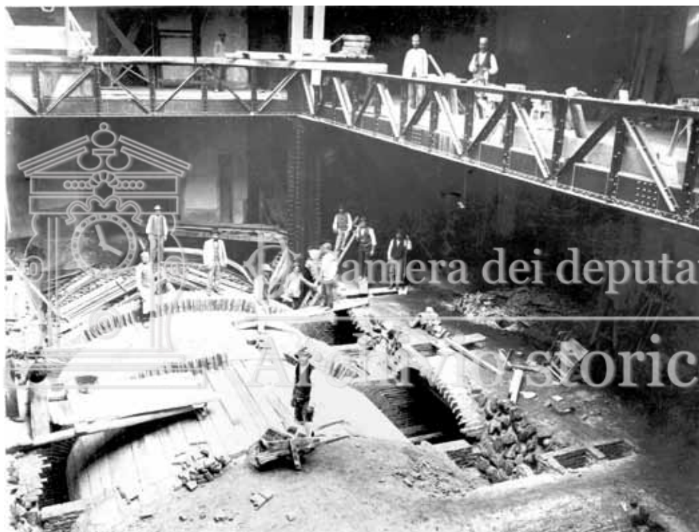
Un cantiere dell'area di Montecitorio nel periodo della realizzazione delle opere di fondazione
