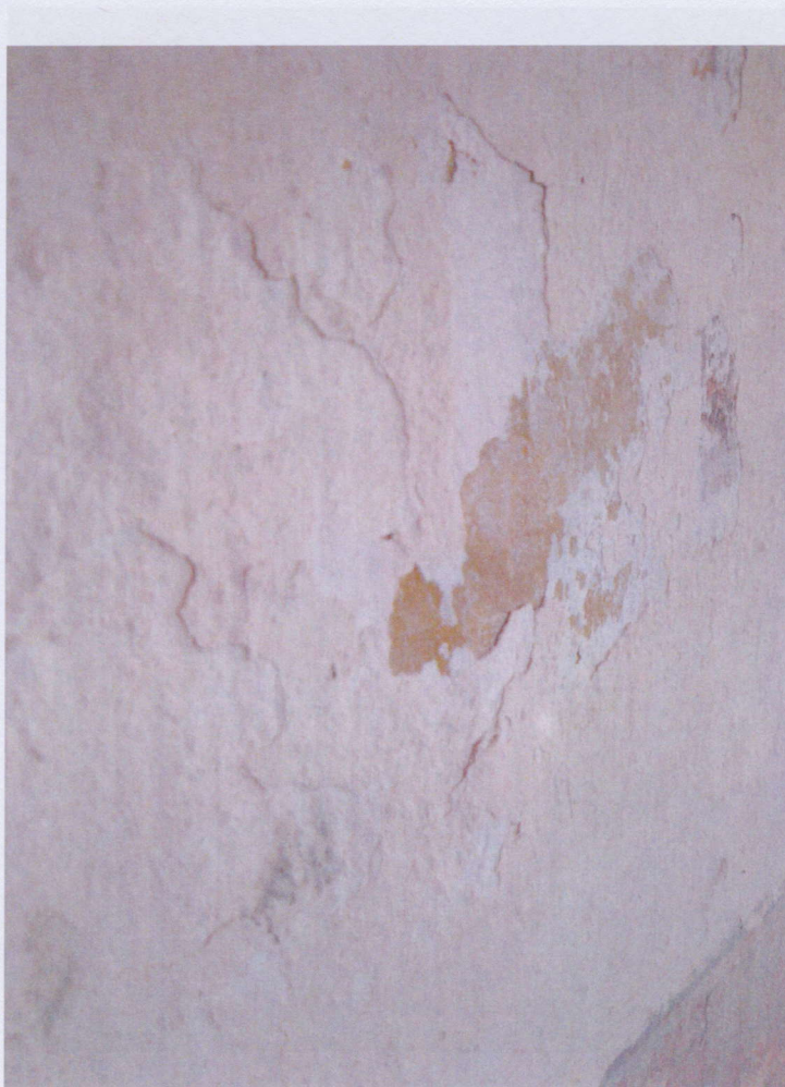
Foto 23. Particolare degli schizzi di calce e del velo rosso diffuso su tutta la superficie.
