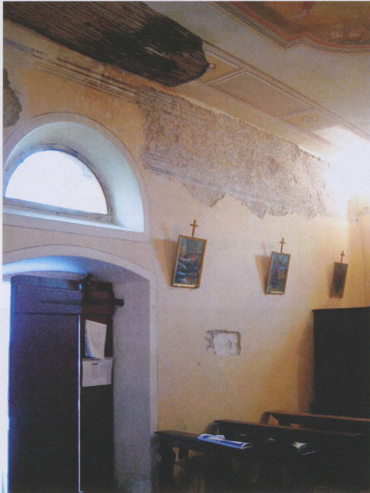
Foto 3. Interno della Chiesa di SS. Vito E Modesto, con parte dei saggi di scoprimento e particolare del tetto.
