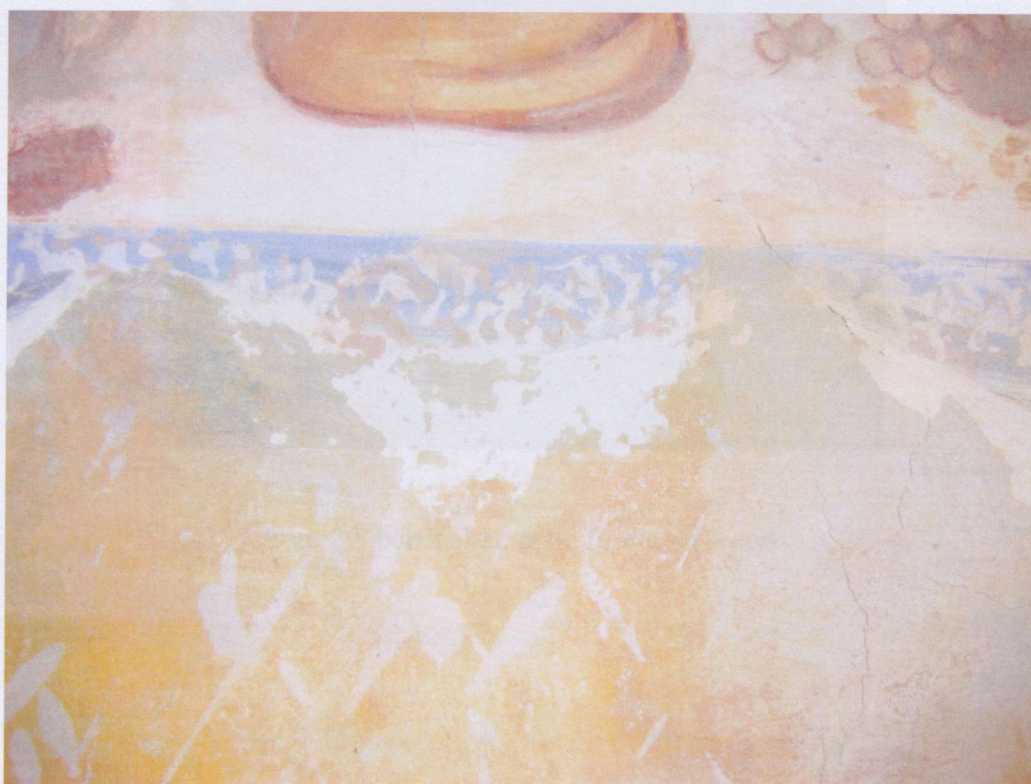
Foto 28. particolare delle finiture a secco.
