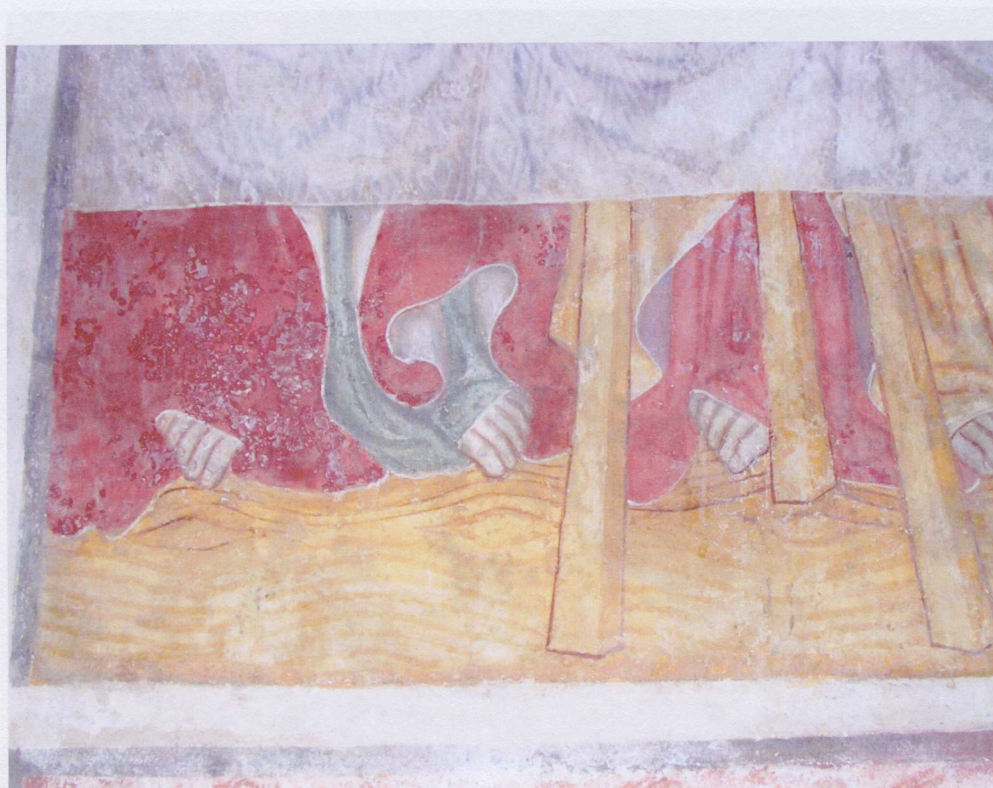
Foto 14. Particolare della pittura pittorica con cadute di colore.
