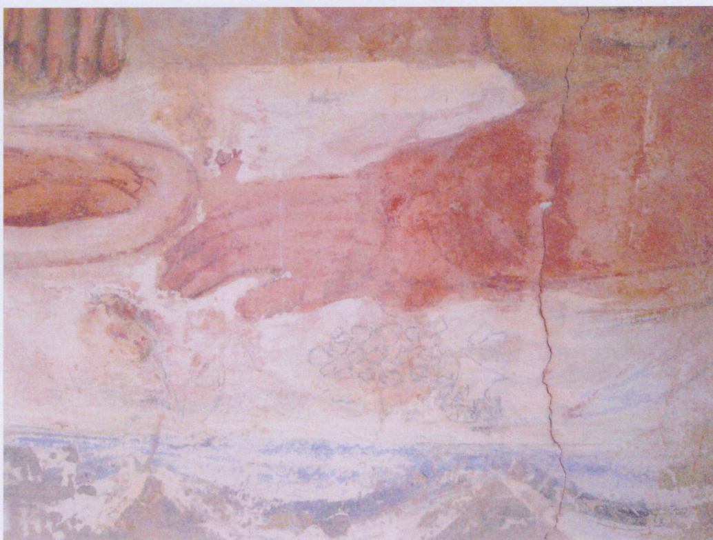
Foto 22. Particolare degli atti vandalici.
