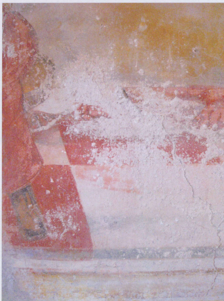
Foto 15. Particolare della superficie con bottacioli e abrasioni.
