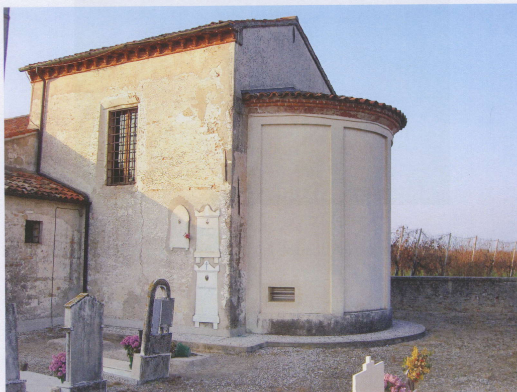
Foto 2. Particolare dell'abside e della zona cimiteriale circostante.
