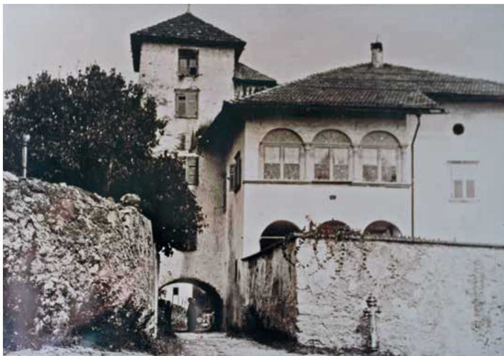
Il Palazzo Spaur di Flavon prima della demolizione della torre passante.
