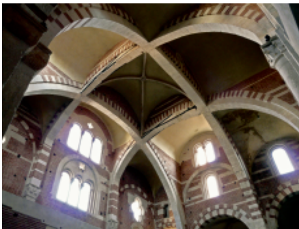
48. Casale Monferrato, cattedrale di Sant'Evasio, dettaglio dell'interno.
