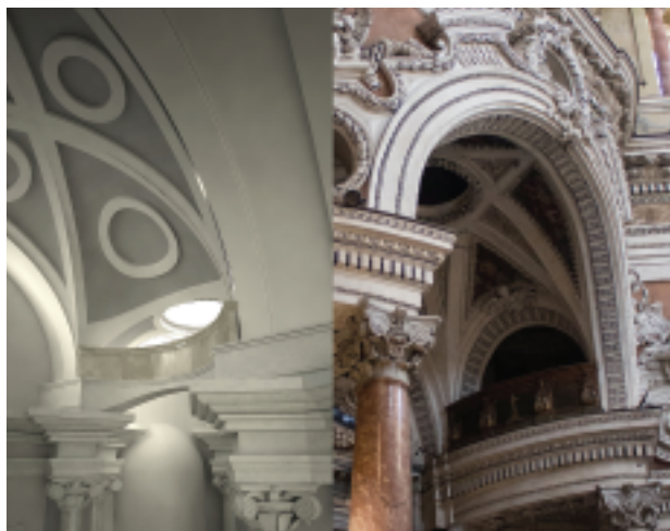
5. Balaustra in curva all'imposta delle volte a crociera a sesto rialzato. Confronto fra le soluzioni proposte da G. Guarini nella chiesa dei padri Somaschi a Messina (a sinistra, ricostruzione digitale di G. Nuccio) e nella chiesa di San Lorenzo a Torino (a destra, foto di G. Nuccio).
