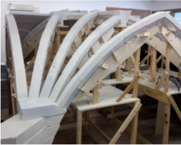
8. Simulazione delle fasi costruttive di una volta costolonata (Università degli Studi di Palermo, Laboratorio di Stereotomia 2016).
