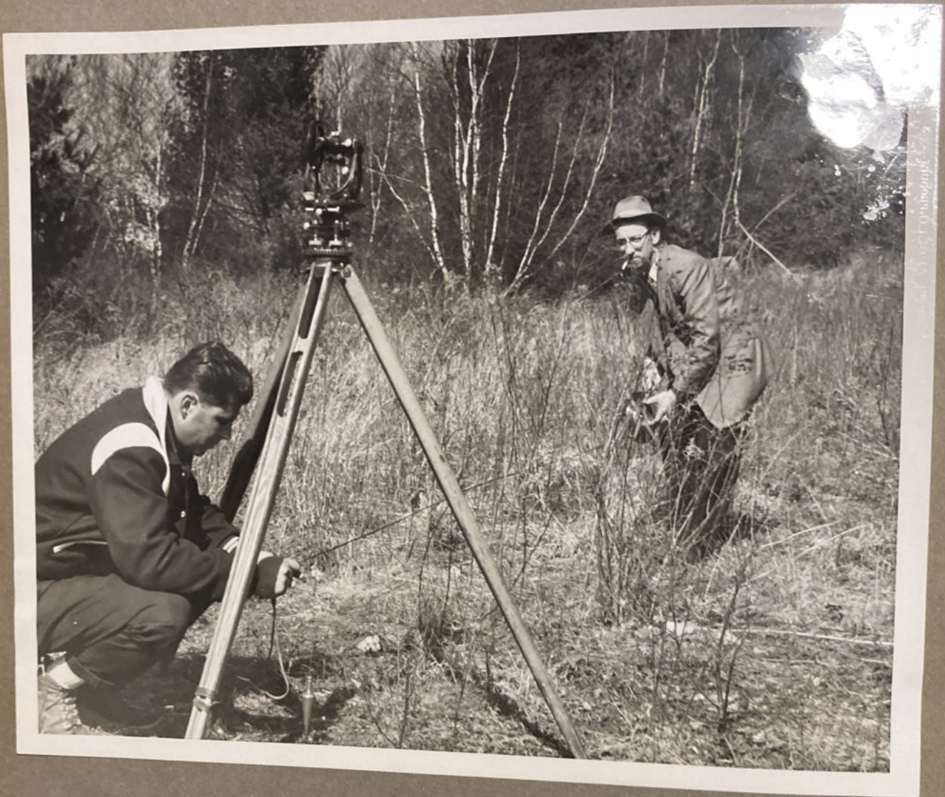
IL GEOMETRA LITUANO DAUGELA E AIUTANTE INIZIANO RILIEVI E MISURAZIONI SUL LUOGO DI COSTRUZIONE DEL PRIMO ISTITUTO SOMASCO IN U.S.A.
