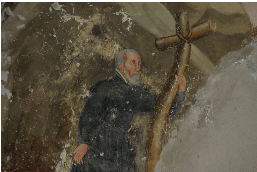
Fig. 17. Macchie e sbiancamenti della pellicola pittorica in corrispondenza del riquadro di "San Girolamo all'eremo", Somasca, Marzo 2015
