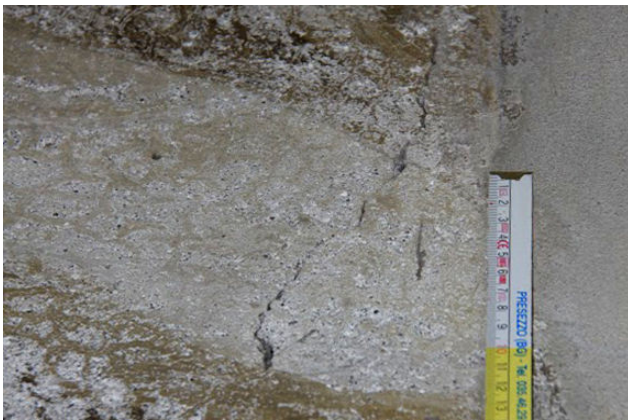
Fig. 18. Particolare della fessura in corrispondenza del riquadro di "San Girolamo riposa meditando il Crocifisso", Somasca, Marzo 2015
