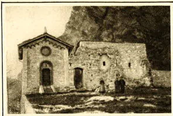
Cappella di Sant'Ambrogio annessa al Castello detto dell'« Innominato ».
