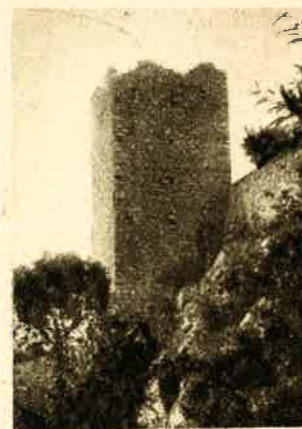
La torre del Castello.
