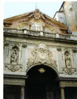
Genova. Chiesa di Santa Maria Maddalena (facciata).
