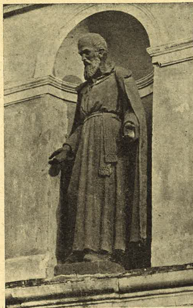
Albera: S. Girolamo Emiliani. Statua in cemento portland. A Somasca, nella nicchia centrale del timpano della Chiesa parrocchiale.
