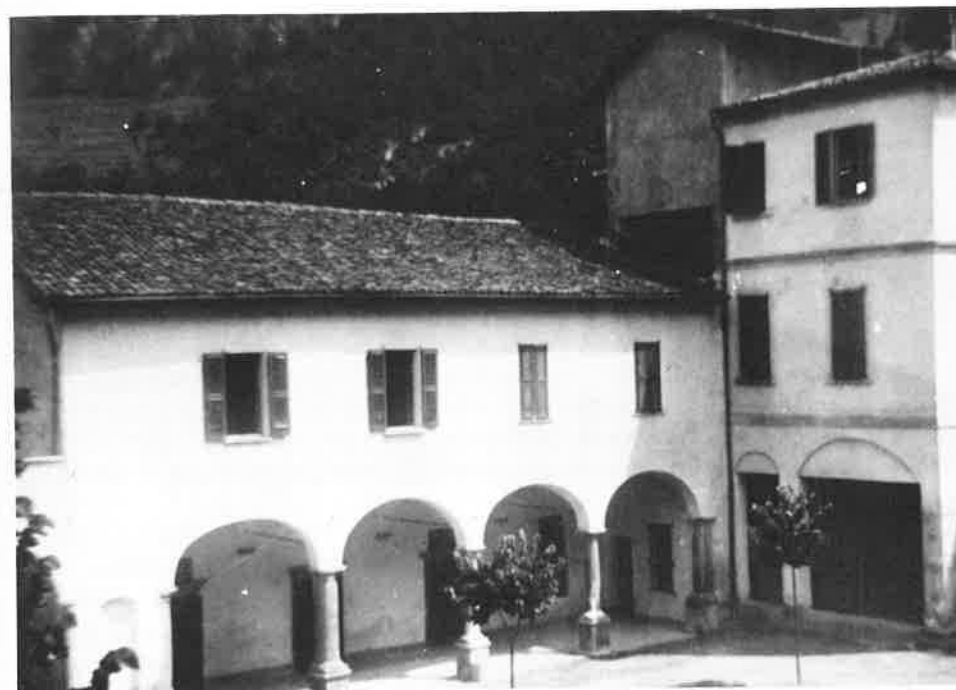
Lato settentrionale del chiostro: sede del Seminario Rurale di San Carlo
