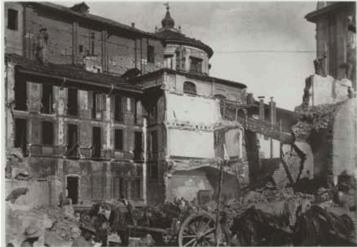
9. Milano, Santa Maria Segreta, esterno, fianco occidentale della chiesa con il collegio in demolizione, 1911 circa. Milano, Archivio Fotografico del Comune, neg. A 1950.
