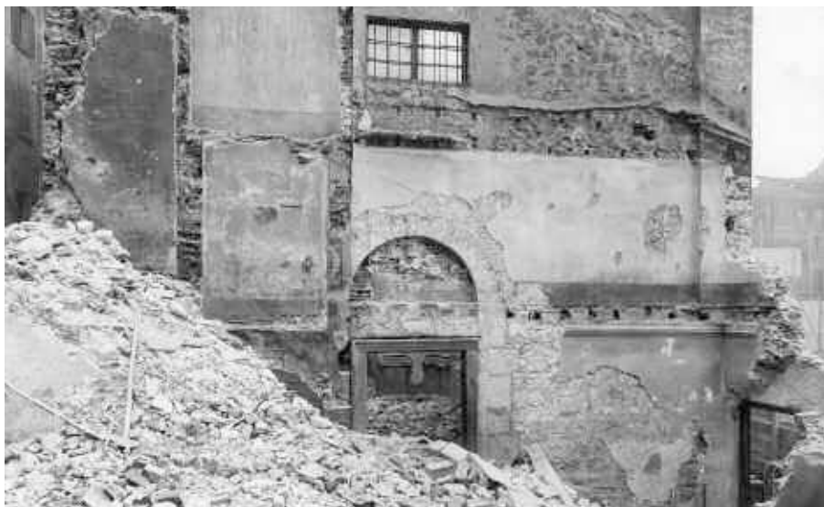
■ Facciata della chiesa medievale di S. Ambrogio in corso di demolizione, 1930 circa (Piazza della Vittoria, AFDM E 97-972)
