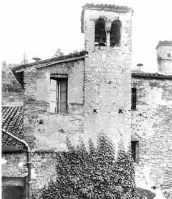
■ Il campanile e l'abside romanica di S. Maria della Consolazione, (Piazzetta delle Consolazioni, AFDM A 470-4852)
