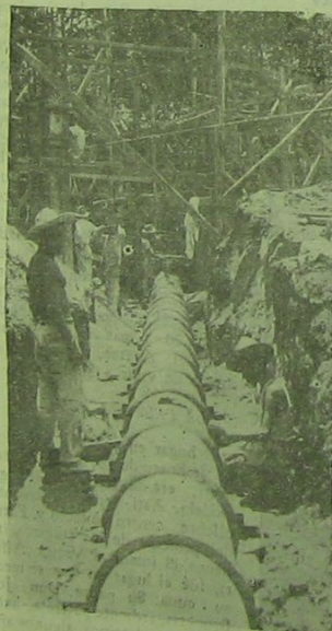
Entre las obras del P. Brunetti se encuentra el Templo Guadalupeño de la Cella cuyos muros están en la tubería y cimientos ya realizados.
