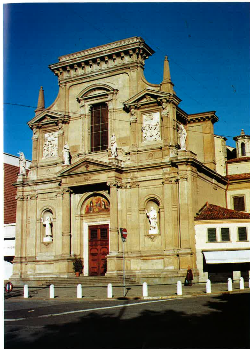
Facciata Chiesa San Bartolomeo / chiude come lo sfondo di un palcoscenico il "Sentierone". 1897 opera dell'ingegnere Giovanni Cuminetti.
