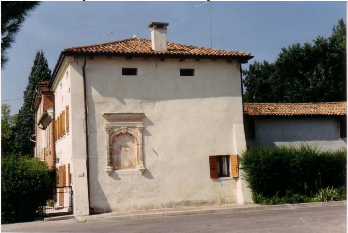
Notare bene che alla base sono stati aggiunti due specie di sostegno in muratura, che di per sé ridicono che si tratta del resto di un più ampio antico edificio.
