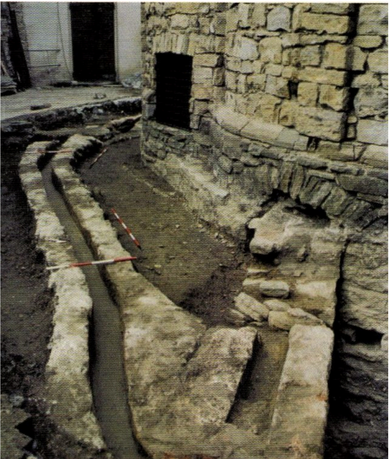
Prima di sfociare nella fontana di Antescholis, l'acquedotto tange l'abside meridionale di Santa Croce, sottopassando un arco in muratura
