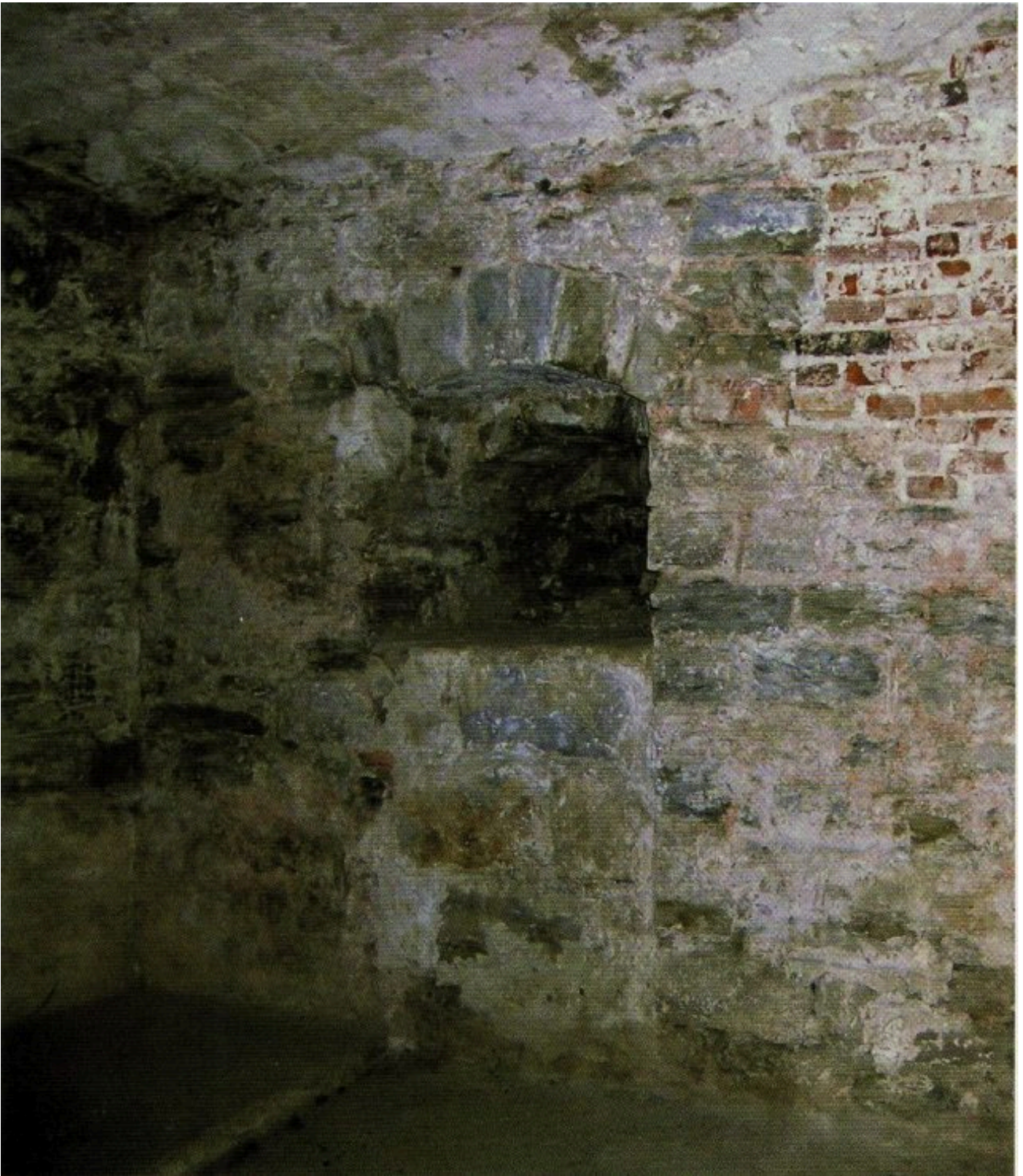
La porta tamponata all'interno di Santa Croce
