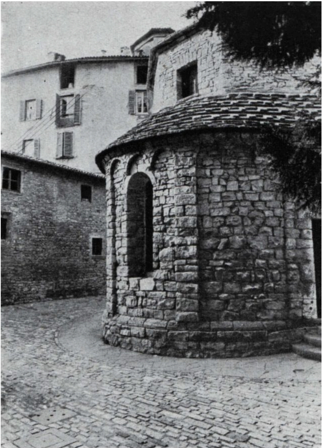
1938: il tempietto dopo la demolizione dei locali contigui, la messa in luce di una delle due monofore ed il restauro. Degli intonaci rimane oggi solo qualche piccolo lacerto; i giunti della muratura esterna furono completamente "ripassati" in cemento e la muratura integrata con intenti mimetici
