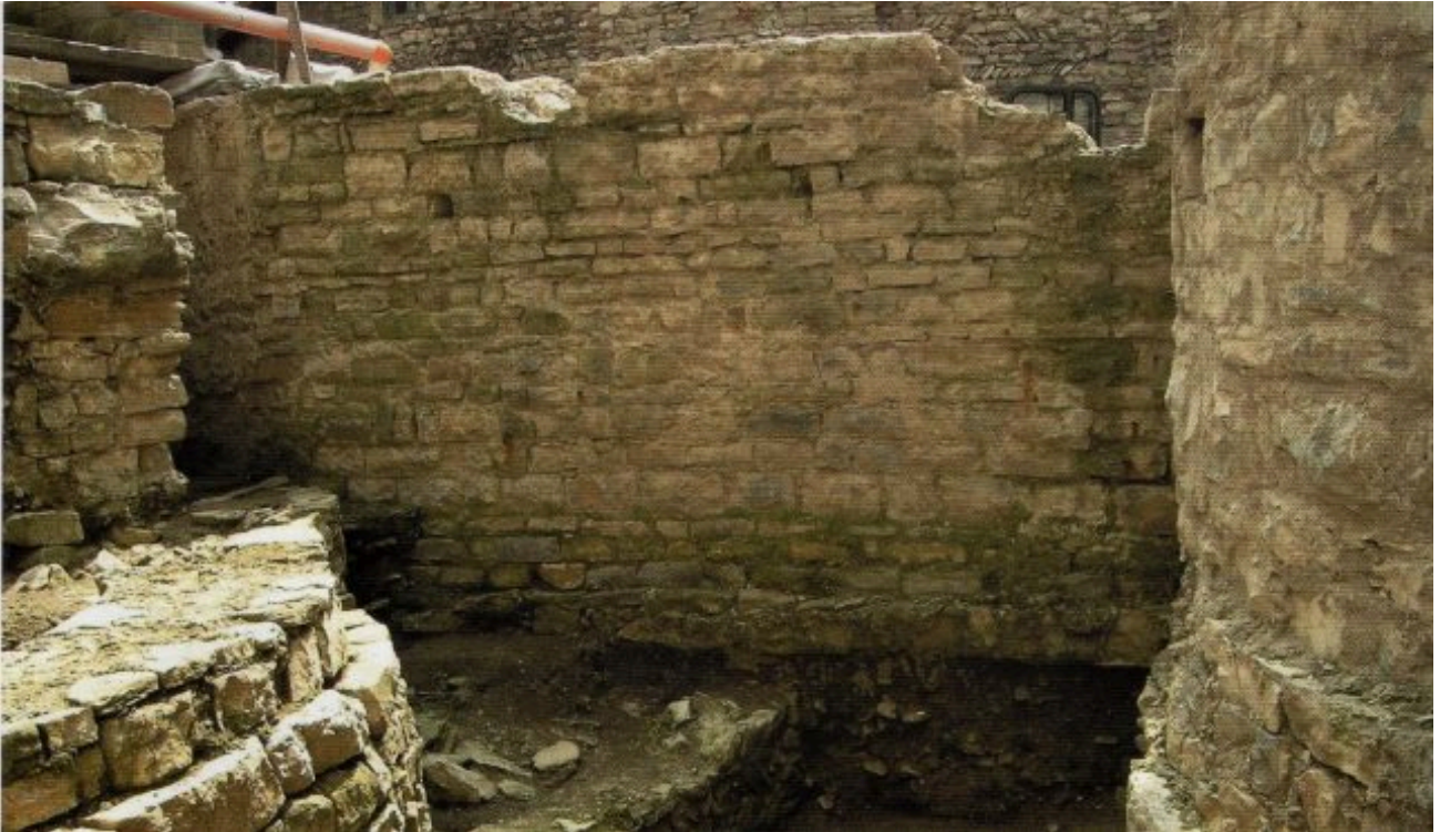
La ben conservata muratura dell'acquedotto, ad andamento est ovest; il canale vero e proprio è largo 25 cm
