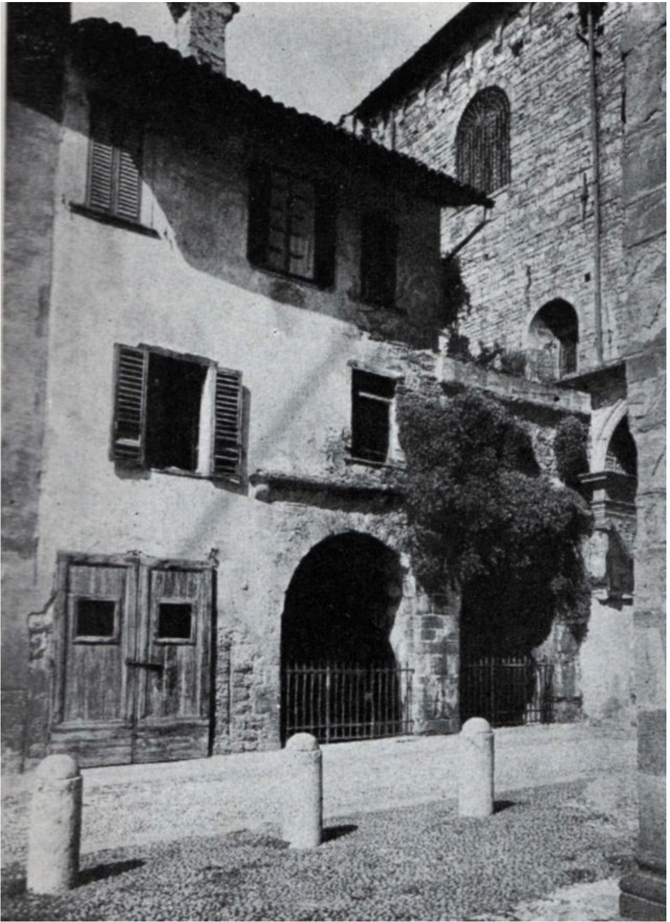
Area di Santa Maria Maggiore. La casa del sacrista sopra la fonte medioevale, come si presentava nel 1934, prima dei lavori eseguiti per il Piano di Risanamento
