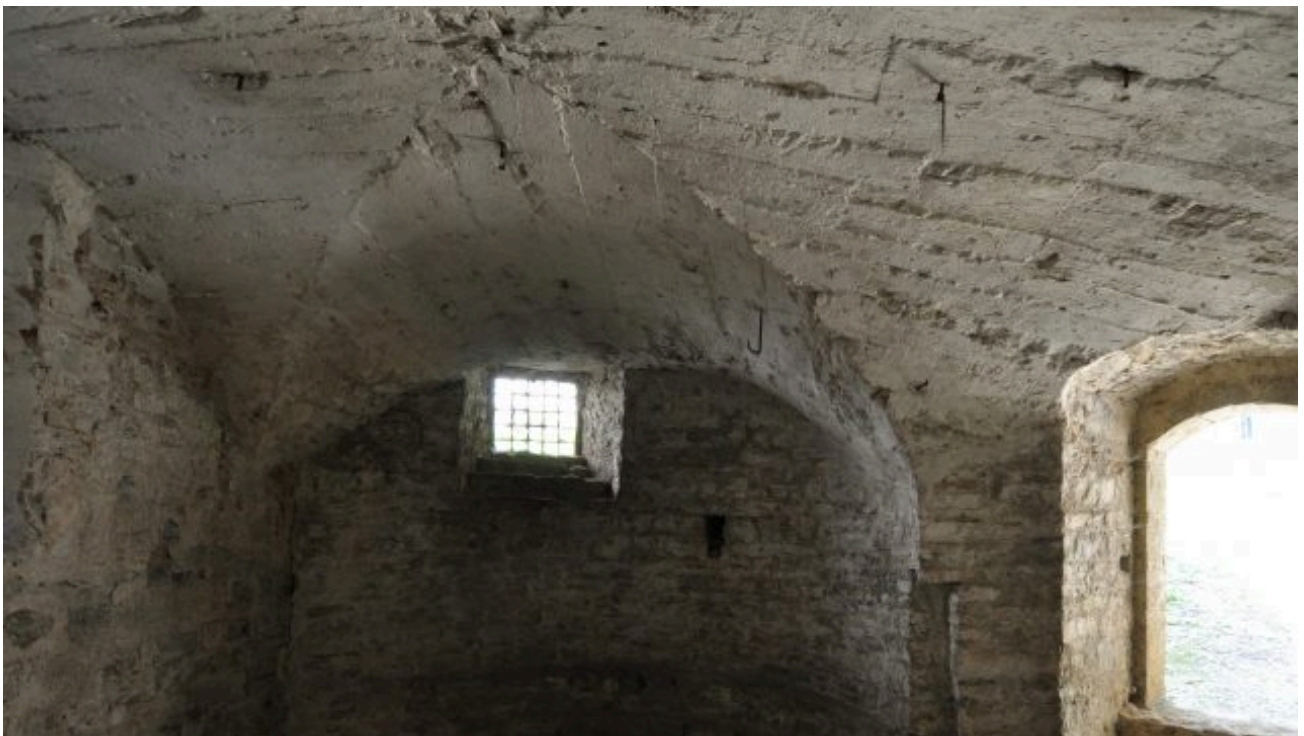
La volta all'interno del vano inferiore di Santa Croce
